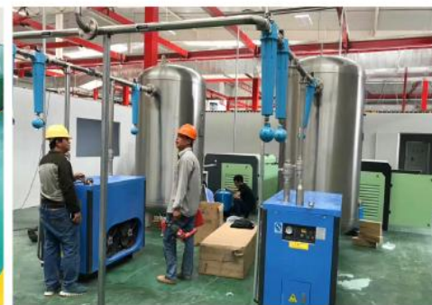
安装服务 Installation service
